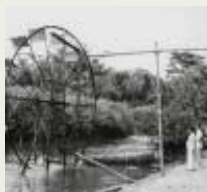
กงล้อวิดน้ำ โดยใช้กำลังงานจากน้ำไหล
