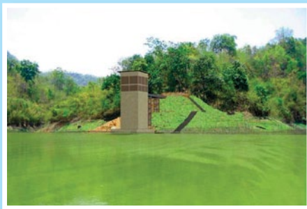
อาคารรับน้ำ
