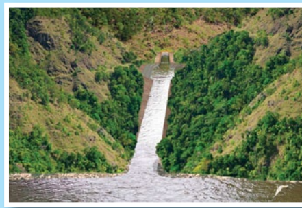
อาคารระบายน้ำท้ายอุโมงค์ส่งน้ำ
