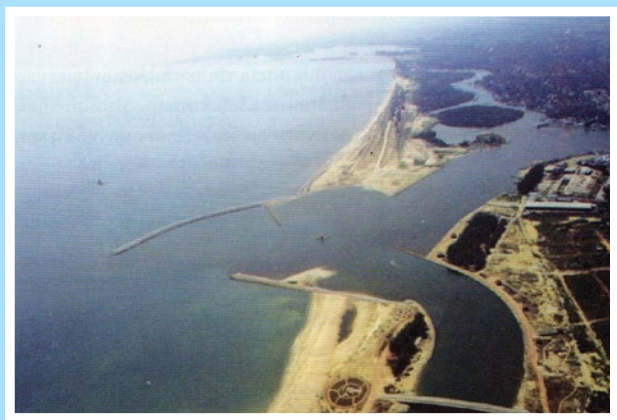
คันกันคลื่น (Breakwater) ของปากแม่น้ำโก-ลก เมื่อสร้างแล้วเสร็จ โดยมีอาคารหลักเล็งจุดแบ่งเขตแดน (Transit Point B) อยู่ตรงกลาง
