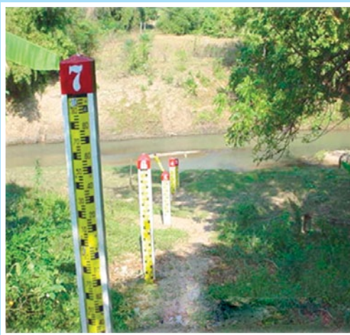
การติดตั้งแผ่นวัดระดับน้ำ
