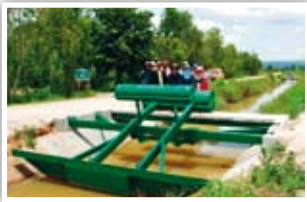
▲ RADA Gate Model II ประตูอัตโนมัติ กลางคลองไฟเบอร์กลาสแบบปรับบานอัตโนมัติ ไร้ต่อมอกัดขวางการไหลของน้ำในคลองแห่งแรกของประเทศไทย พัฒนาขึ้นโดยสำนักวิจัยและพัฒนา ก่อสร้างที่คลอง 1R-L กม. 2 + 850 โครงการอ่างเก็บน้ำห้วยหวดอันเนื่องมาจากพระราชดำริ จังหวัดสกลนคร
