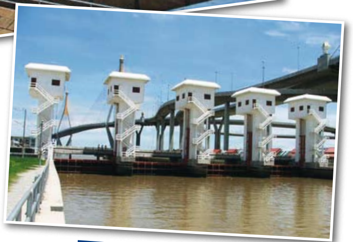
ประตูระบายน้ำคลองลัดโพธิ์
