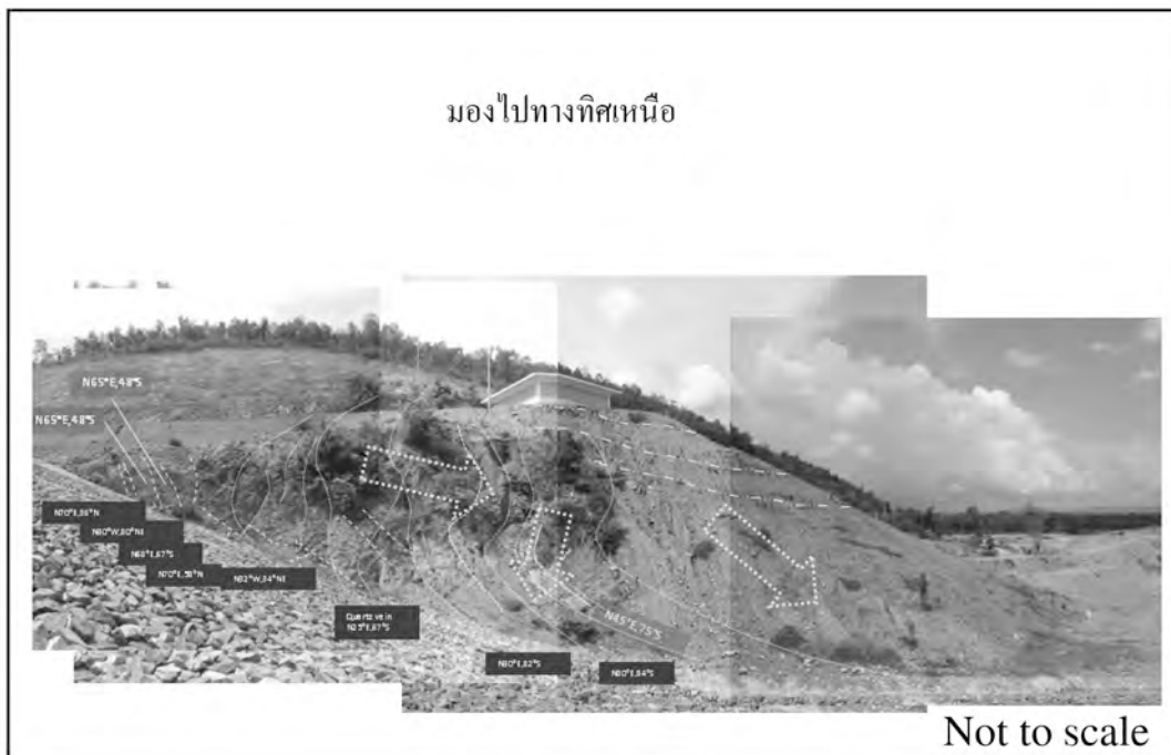
ภาพที่ 2 ผนังหินมุมชันที่รองรับอาคารท่อส่งน้ำ และการวางตัวของระนาบรอยแตก
