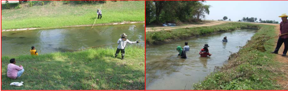
รูปที่ 2 การเก็บกำจัดวัชพืชด้วยแรงงาน ทำให้ล่าช้า และ ประสิทธิภาพต่ำ
