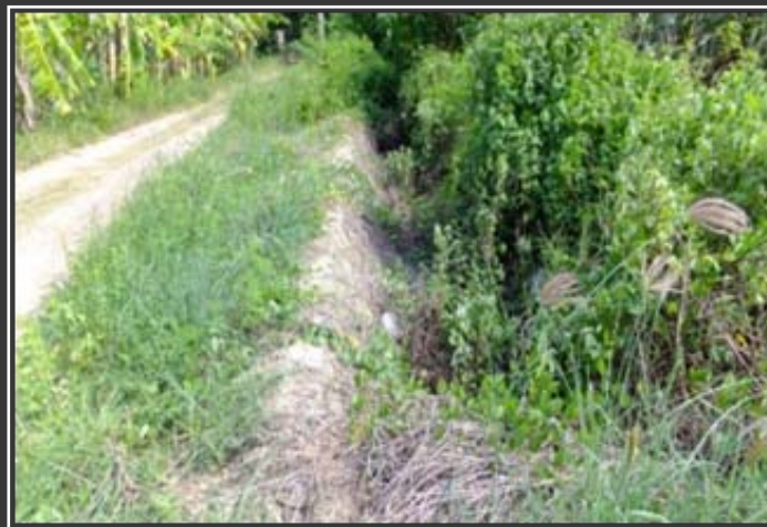
คูส่งน้ำรกร้างไม่ได้ใช้งาน
