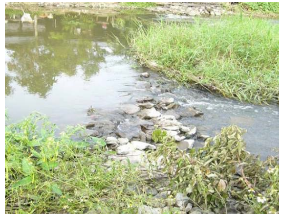
ภาพที่ 5 สภาพเหมืองส่งน้ำที่มีวัชพืชและฝายหินทั้ง
