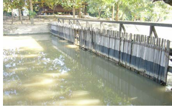
ภาพที่ 3 สะพานไม้อัดน้ำ
