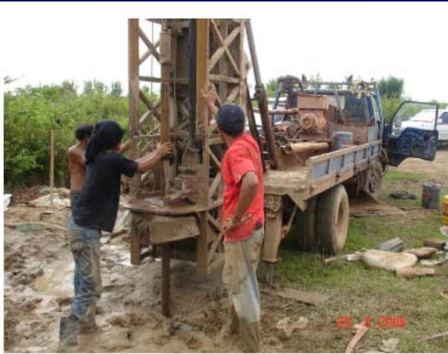
เจาะและก่อสร้างบ่อบาดาล
