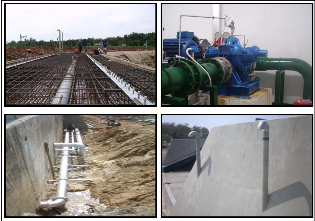
รูปแสดงงานติดตั้งระบบท่อภายในและภายนอกห้องควบคุมฝ่ายช่าง และท่อระบายความดัน (Vent Pipe)
