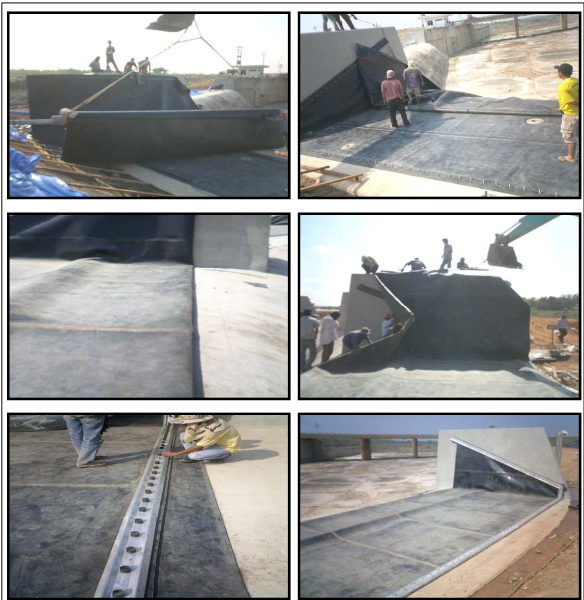
รูปแสดงการปูแผ่นยางตัวฝายยาง (Rubber Bag Body)
