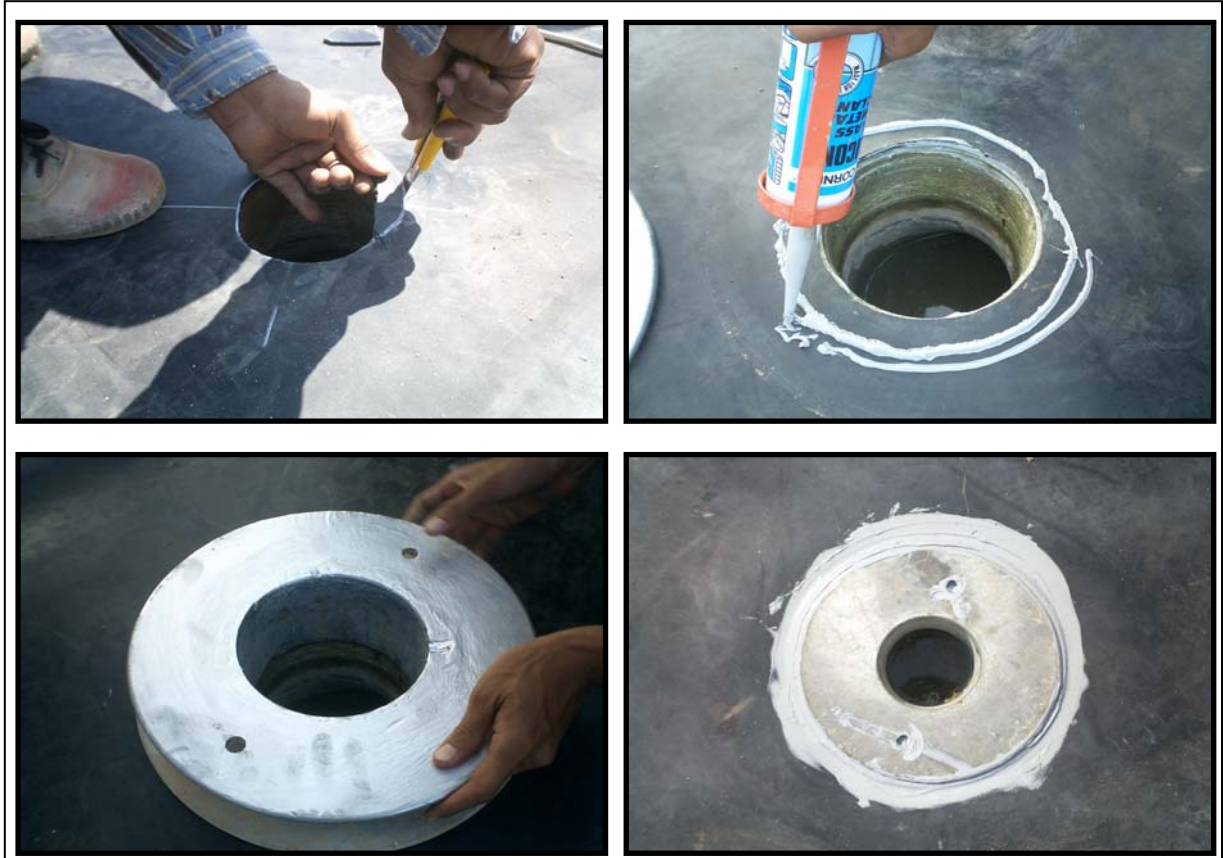
รูปแสดงการติดตั้ง In/Outlet (ปากทางเข้า - ออกของน้ำ)
