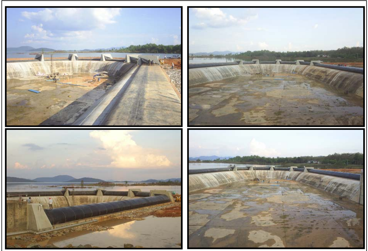
รูปแสดงการพองตัวฝายยางขนาดความสูงต่างๆเพื่อทำการทดสอบ
