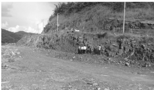
รูปที่ 7 แสดงสภาพของหินทรายแป้ง (Siltstone) ที่มีการผุพังแตกตัวในสภาพแห้ง (slaking)
