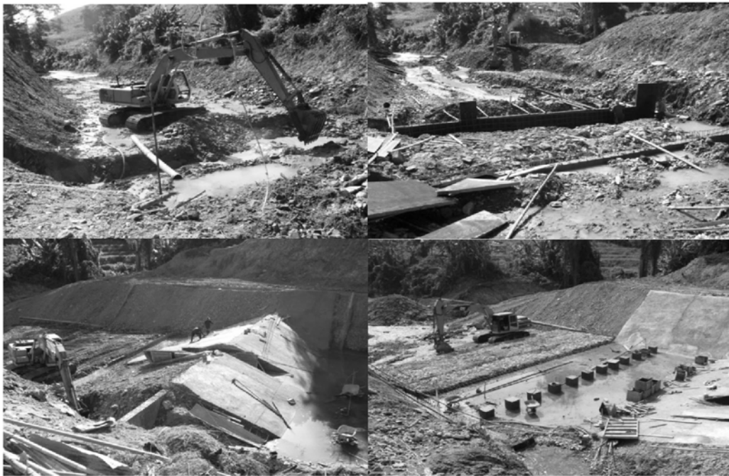
รูปที่ 8 การก่อสร้างฝายอนุรักษ์ต้นน้ำลำธารแบบถาวร (คอนกรีตเสริมเหล็กแบบสันกว้าง)
