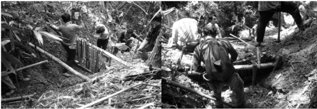
รูปที่ 7 การก่อสร้างฝายอนุรักษ์ต้นน้ำลำธารแบบท้องถื่นเบื้องต้น (ฝายคอกหมู)
