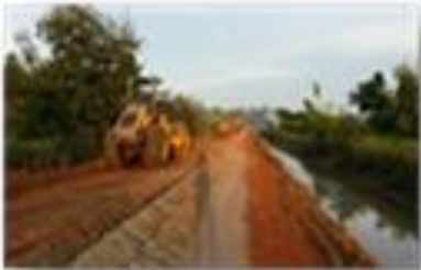
คลุกเคล้าดินให้ความชื้นสม่ำเสมอ บดอัดดินให้ได้ความแน่นตามมาตรฐาน
