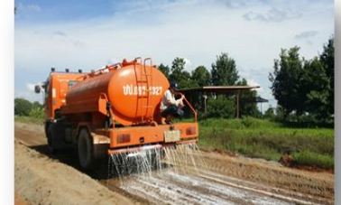
ฉีดน้ำผสมน้ำยางให้ได้ความชื้นที่เหมาะสม
