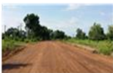
คลุกเคล้าดินให้ความชื้นสม่ำเสมอ บดอัดดินให้ได้ความแน่นตามมาตรฐาน
