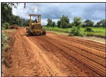
ภาพที่ 8 ตะกรูยผิวหน้าดินลูกรัง
