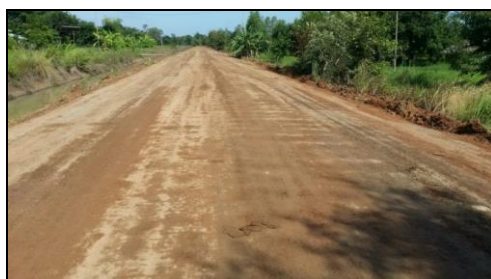
ภาพที่ 18 ผิวหน้าดินซีเมนต์ผสมยางพารา ภาพที่ 19 ถนนลูกรัง (F6) ก่อนดำเนินการ อายุ 1 วัน หลังดำเนินการ
