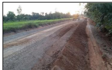
ภาพที่ 12 คลุกเคล้าให้เข้ากัน
