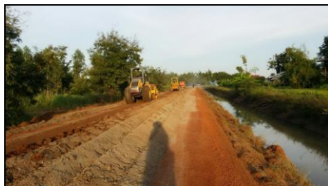
ภาพที่ 16 บดอัดดินให้ได้ความแน่นตามมาตรฐาน ภาพที่ 17 ทดสอบความหนาแน่น โดยวิธี Sand Cone
