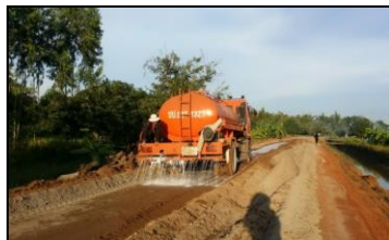
ภาพที่ 13 ผสมน้ำกับน้ำยางชั้น ภาพที่ 14 ฉีดน้ำผสมน้ำยางให้ ภาพที่ 15 คลุกเคล้าดินให้ และสารผสมเพิ่มให้เข้ากัน ได้ความชื้นที่เหมาะสม ความชื้นสม่ำเสมอ
