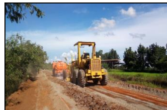
ภาพที่ 13 ผสมน้ำกับน้ำยางชั้น ภาพที่ 14 ฉีดน้ำผสมน้ำยางให้ ภาพที่ 15 คลุกเคล้าดินให้ และสารผสมเพิ่มให้เข้ากัน ได้ความชื้นที่เหมาะสม ความชื้นสม่ำเสมอ
