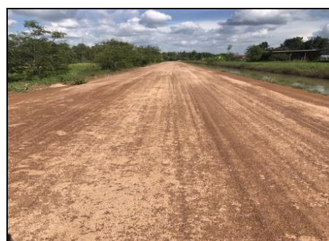
ภาพที่ 20 ผิวหน้าดินซีเมนต์ผสมยางพารา ภาพที่ 21 ผิวหน้าดินซีเมนต์ผสมยางพารา อายุ 1 วัน หลังดำเนินการ อายุ 30 วัน หลังดำเนินการ
