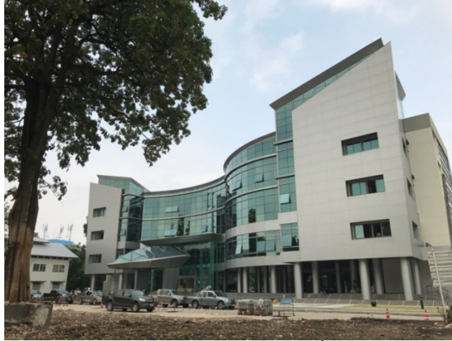
อาคารควบคุมและติดตามการบริหารจัดการน้ำเพื่อการชลประทาน (ความก้าวหน้าในการก่อสร้างเมื่อ 20 พ.ค.2560)
